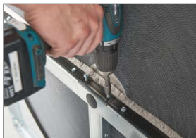
(4) Lösen Sie die Befestigungsschrauben der Lagerabdeckung
