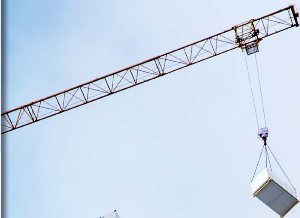
Dank Stahlträgerkonstruktionen, die von TROX auf Wunsch angefertigt werden, können Einheiten bis zu 14 x 2,50 m komplett vormontiert angeliefert werden.
